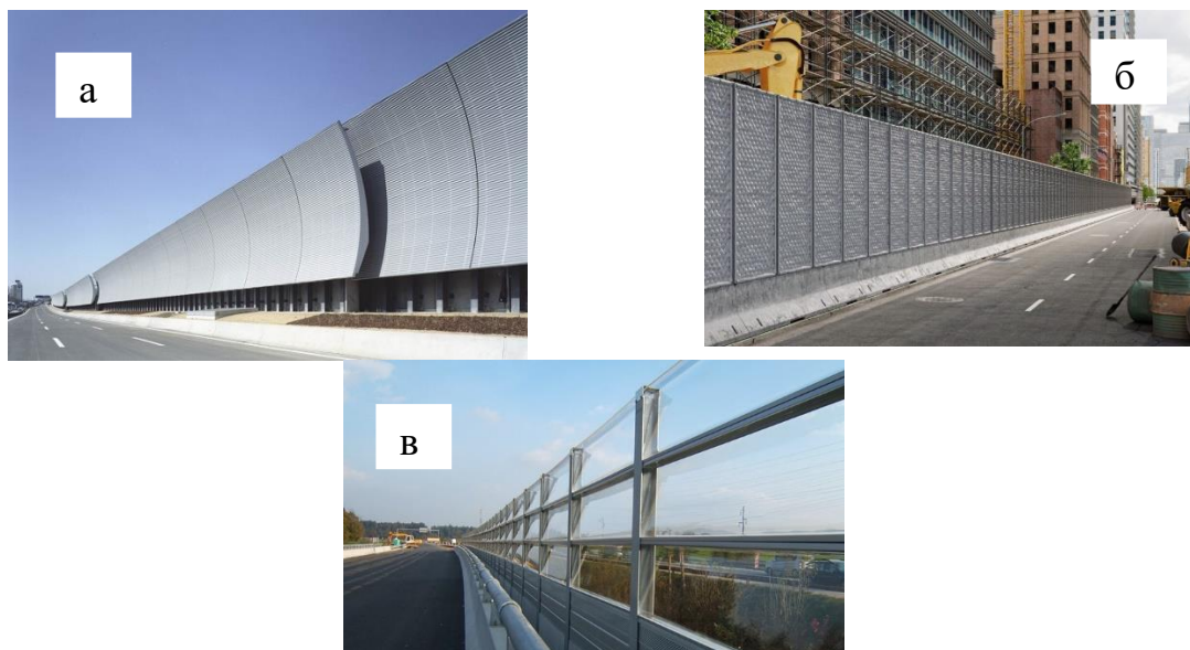
Рис. 1 – Приклади шумозахисних екранів в Німеччині (а, б) і в Нідерландах (в)
