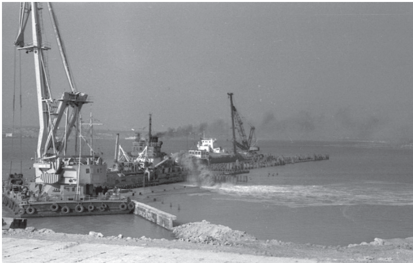
Рис. 5. Будівництво причалів (Найкрацій порт, 2021)
