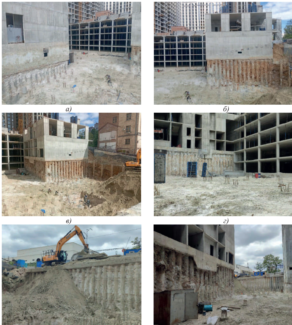
Рис. 3. Стадія будівництва житлового комплексу (серпень 2025 року) (а; б; в; г — вигляд зі сторони вул. Предславинської; г; д — підпірні стінки, пальовий фундамент)
