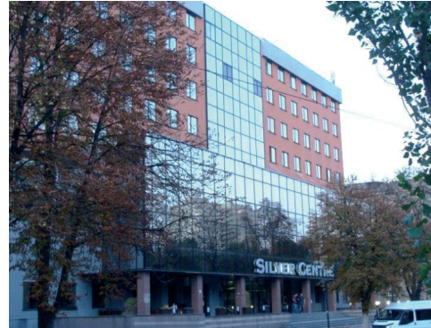
Рис. 5. Бізнес-центр «Сільвер Центр» (фото В. Щабельської)
