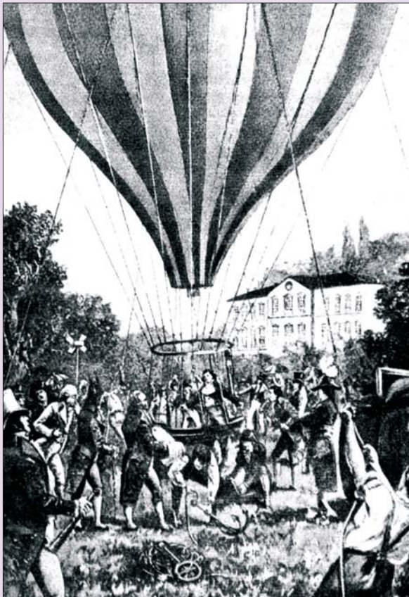
Шарльер — аэростат с оболочкой, наполненной водородом. Назван так по имени изобретателя Жака Александра Сезара Шарля. Первый полет совершил 27 августа 1783 года.
