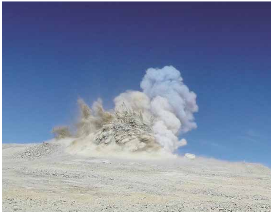
▲ Верхняя часть 3000-метрового пика Серро Армазонес была снесена мощным взрывом в ходе подготовки площадки для строительства самого большого в мире оптического/инфракрасного телескопа.
