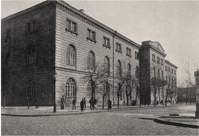
Головна будівля Імператорського Новоросійського університету (1894 р.). Зображення з листівки.
